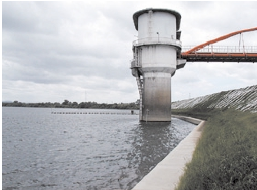
【取水塔(阿賀野川浄水場)】
