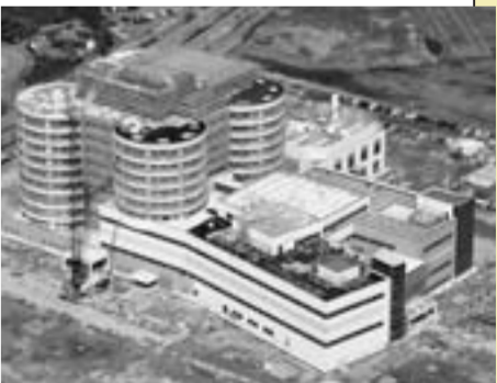
11月1日の開院に向け、着々と準備が進む新・市民病院(中央区・鐘木)
